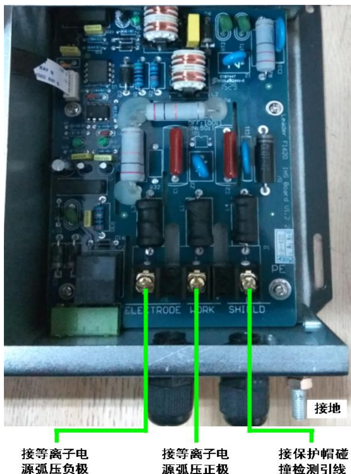
图 3.8 分压板接口接线
